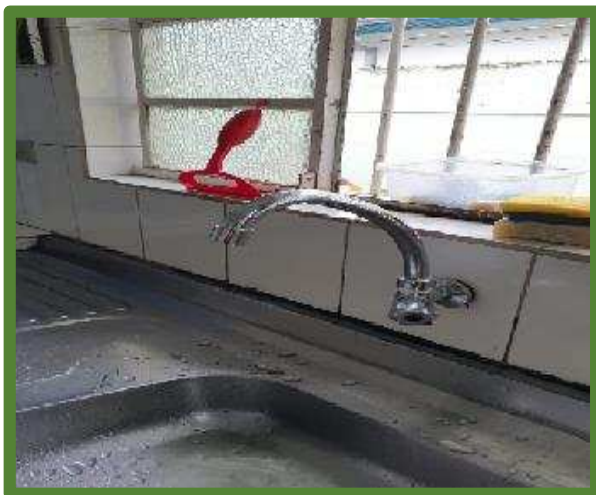
MANUTENÇÃO DA TORNEIRA QUE ESTAVA VAZANDO
